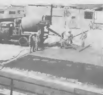
PA ASEGURA cu e formate y latanan ta wordé poní nivel, un waterpas ta sirbi como un referensia constante. Entru e formate cu canal di bera poni, concreto ta wordé bashá, como 3 1/2 yarda cubico.
